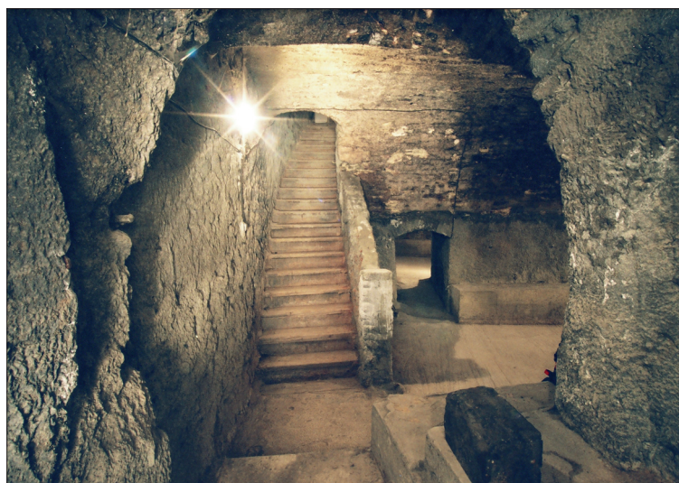
Vstupní schodiště. Zajímavá je hloubka sklepení a kamenné valené klenby s původními otisky šalovacích prken (1).
