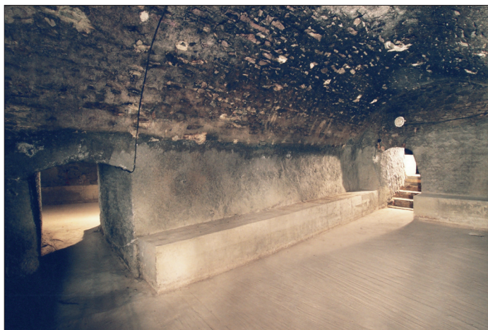
Největší prostor sklepení s novodobými statickými úpravami (2).
