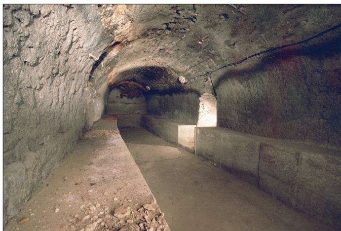
Místnost podél obvodové zdi Dolního náměstí s větracími okénky a dvěma valenými klenbami, v popředí starší kamenná, vzadu renesanční cihlová (3).
